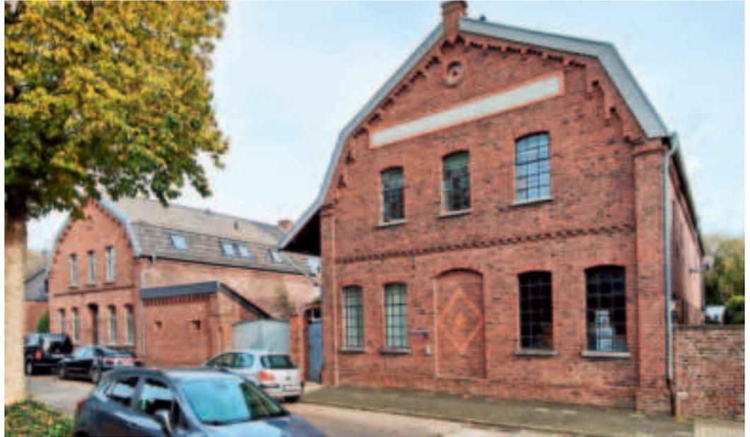
Straßenansicht: Die beiden langgestreckten, zweigeschossigen Bauten sind mit einer Mauer verbunden. Beim ehemaligen Produktionsgebäude im Vordergrund sind Sprossenfenster aus Walzeisenprofilen eingelassen. Das von einer Ziegelreihe gerahmte Putzband unterhalb des Giebels war vermutlich für eine Firmenaufschrift vorgesehen.
