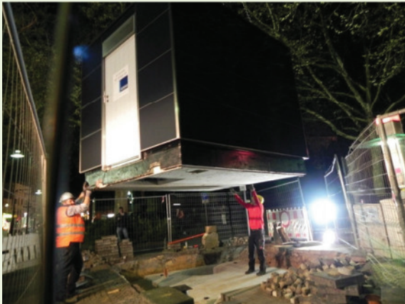
Montage der WC-Anlage
