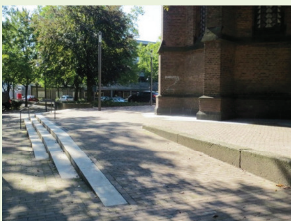
Treppen-/Rampenanlage hinter der Kirche
