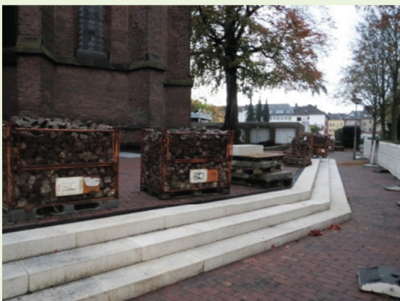
Bauarbeiten im Kirchem Umfeld
