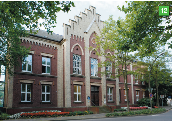
Ehemalige Höhere Bürgerschule, heute Standesamt
